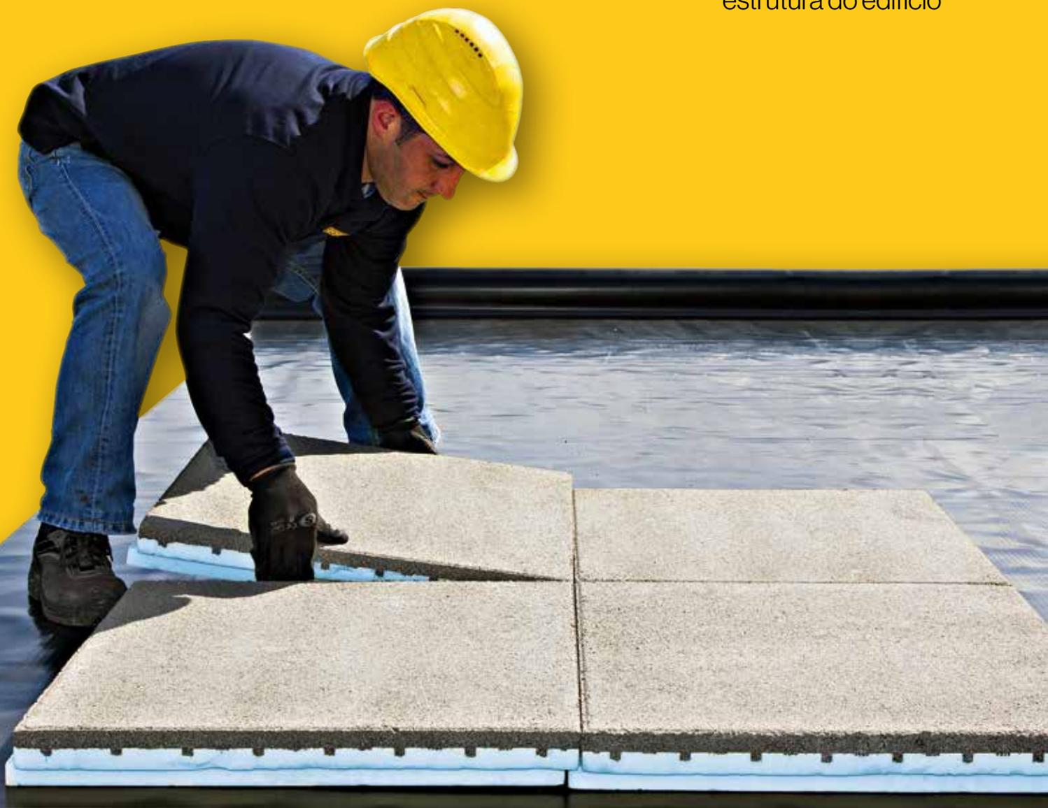
As lajetas térmicas Grisol® **surtem como uma evolução dos sistemas de cobertura invertida**, aliando às vantagens deste sistema uma maior facilidade de aplicação e tornando esta solução de isolamento mais versátil, eficiente e prática.
