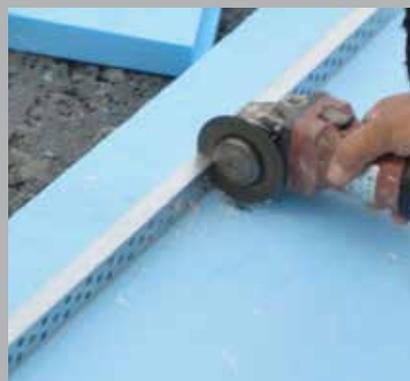
O modo de aplicação é simples: basta colocar a primeira fila de placas, tendo em conta as dimensões para o beirado desejado, e a partir dessa fila colocar alternadamente placas de um e dois perfis. A fixação pode ser realizada através da aplicação de buchas, ou em certos casos através de uma colagem adequada. Devem ser colocadas quatro fixações por placa.
